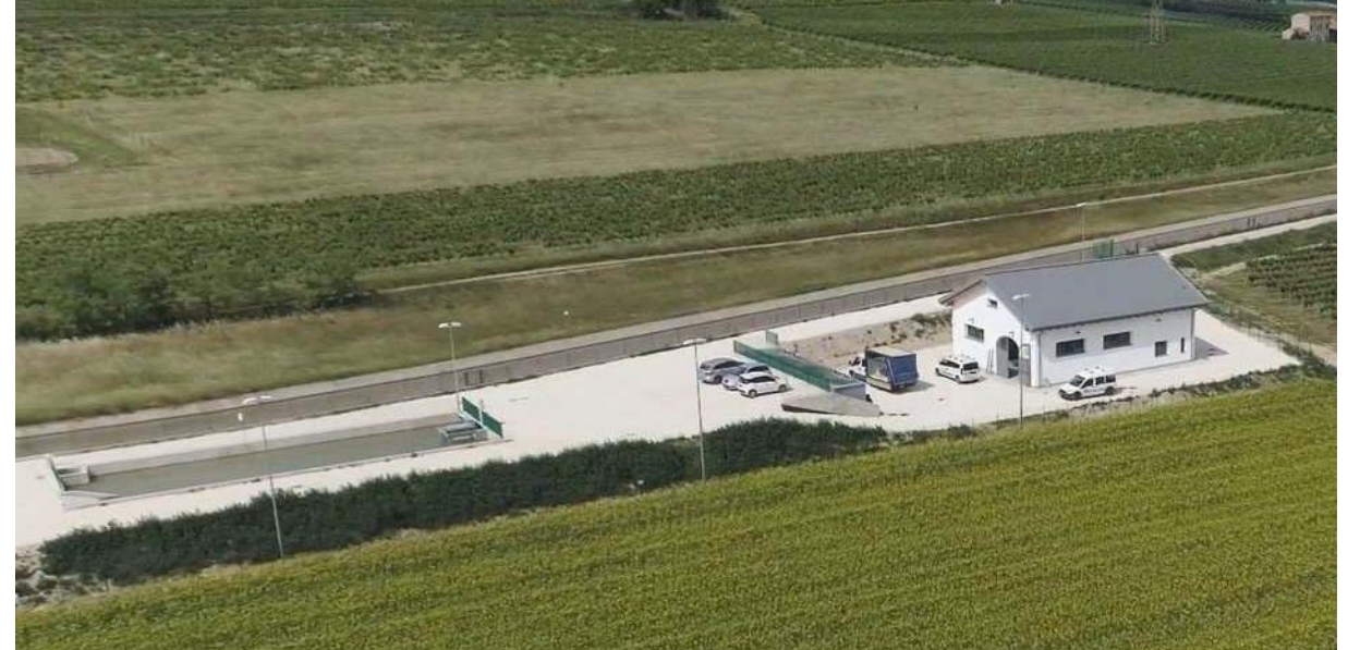
Centrale di sollevamento e vasca dissabbiatrice – Impianto irriguo Coronini
