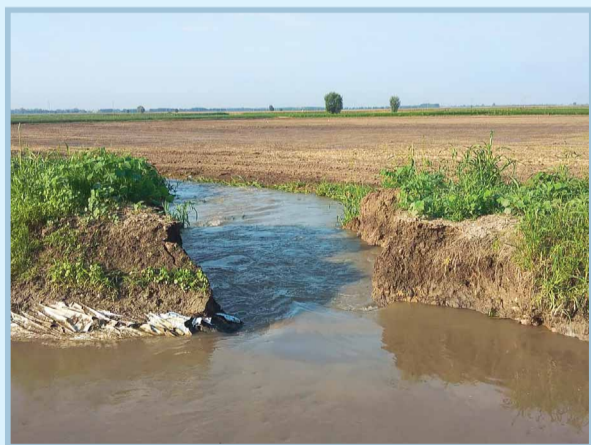
Il crollo dell'argine dello scolo Focchiara provocato dalle nutrie. A destra, l'intervento a Pontepossero di Sorgà
