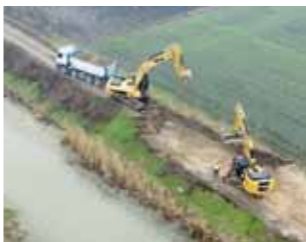
Lavori del Consorzio di Bonifica
