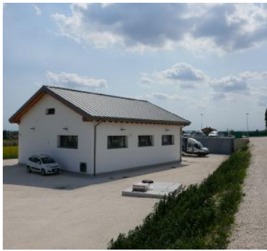
La centrale La struttura da cui si snoda le rete in pressione a Coronini
