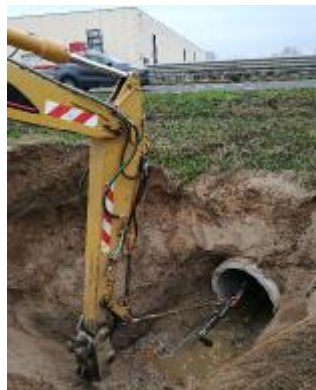
Una fase dei lavori
