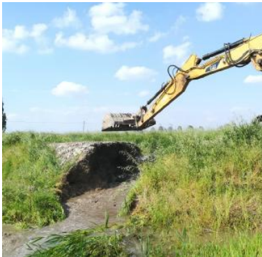
L'enorme galleria scavata dalle nutrie sull'argine del Focchiara
