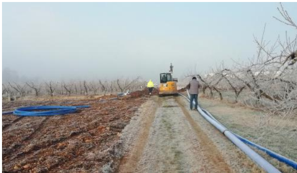
Lavori di posa della tubazione Pead
