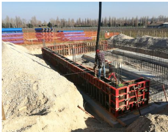
Lavori per la costruzione della centrale di pompaggio FOTO PECORA
