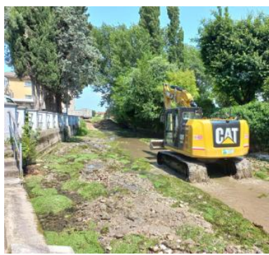
L'intervento Una ruspa all'opera sull'argine del Tartaro
