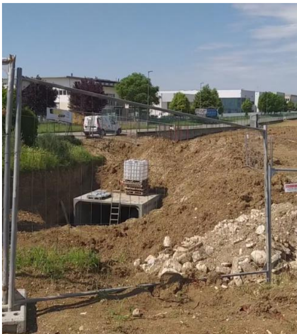
I lavori per la realizzazione dello scolmatore ad Arbizzano
