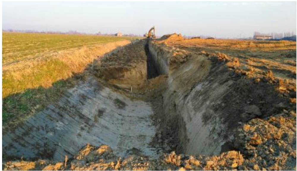
Il cantiere aperto dal Consorzio di bonifica veronese per mettere in sicurezza la frazione di Bionde
