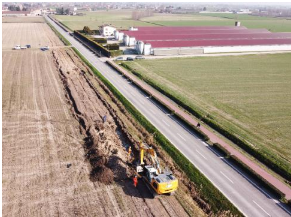
I lavori avviati dal Consorzio a Ca' degli Oppi dove verrà convertito il vecchio bacino idrico
