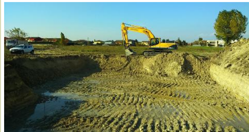
I lavori in corso lungo il Menago per la realizzazione di una delle due vasche di laminazione
