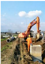
La posa di alcune tubature
