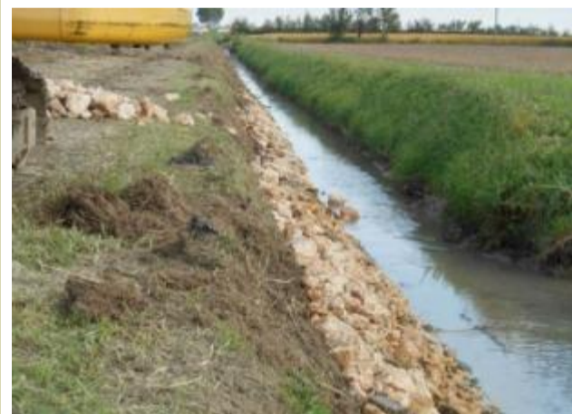
Lavori di arginatura
