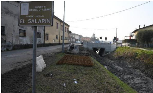
I lavori all'alveo del canale raccoglitore in località El Salarin FOTOPECORA
